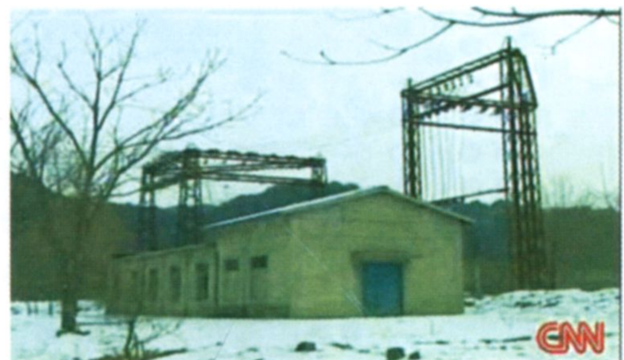
شكل (٣٧) : مبنى مضخات المياه لدائرة التبريد الثالثة القريب من برج التبريد للمفاعل الكوري وتظهر في الصورة كابلات قوية لنقل الكهرباء
