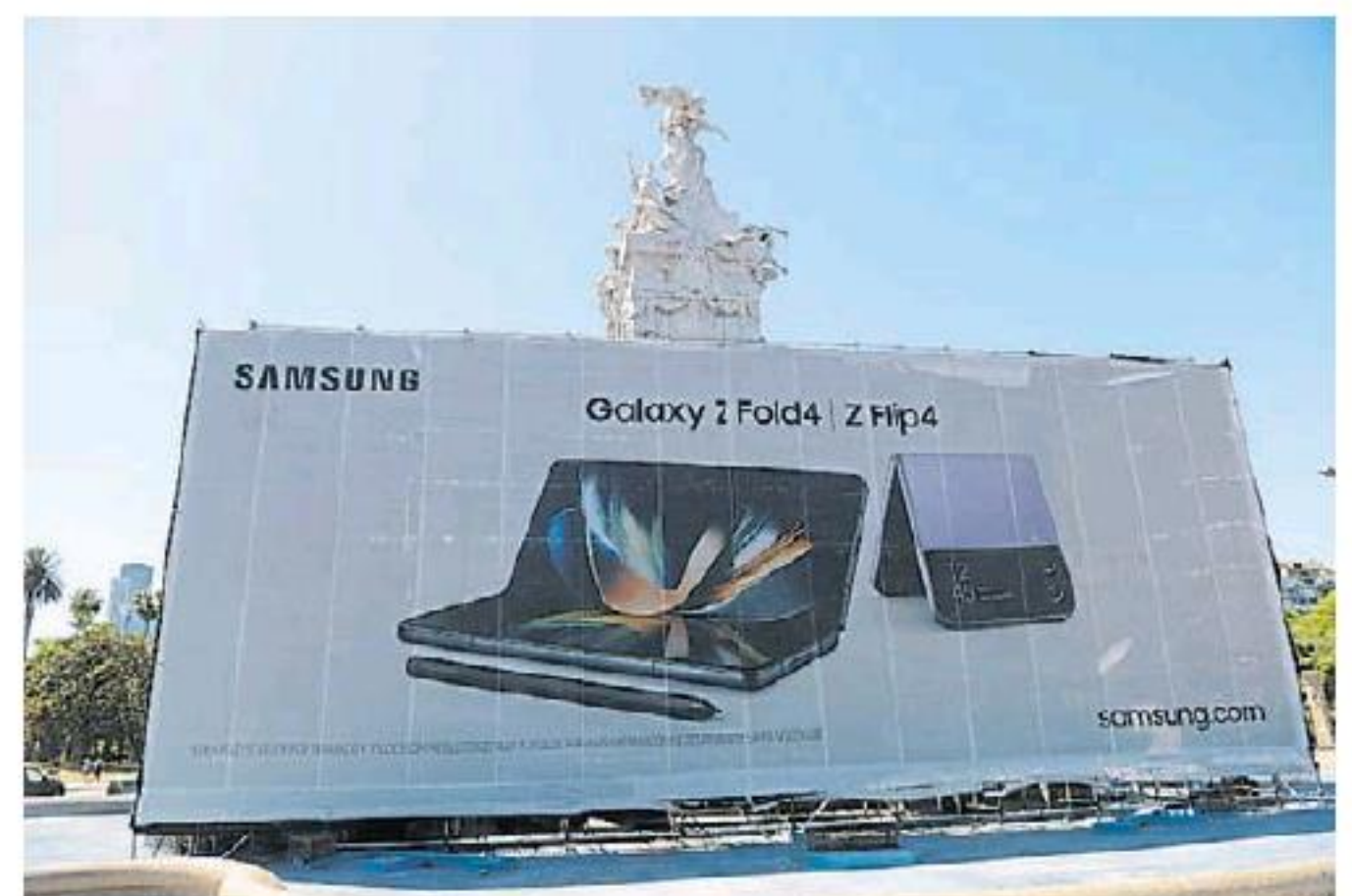
Monumento a los Españoles. Resta volver a instalar piezas reparadas.
